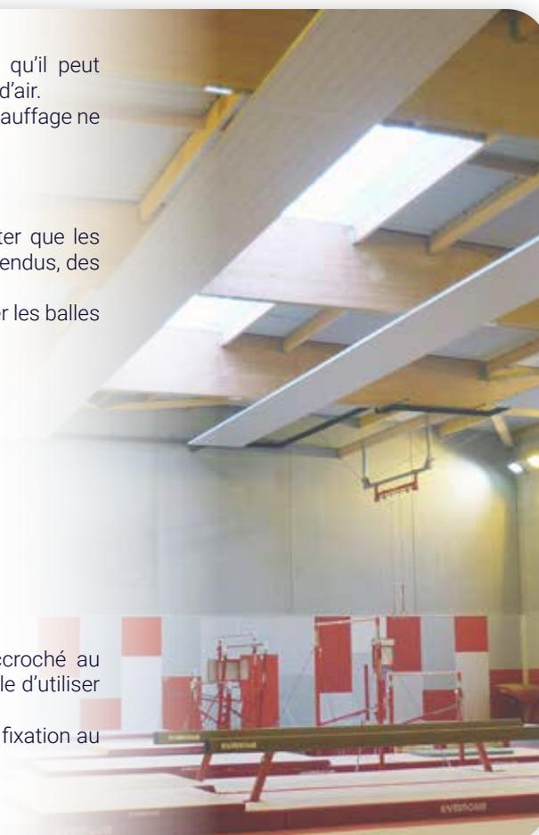
Les panneaux PREC X peuvent être équipés en usine de trous de 18 mm aux emplacements de fixation dans le plafond, ainsi la fixation directe est possible.
